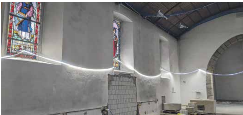
Im Kirchengebäude ist die Renovation in vollem Gange.
